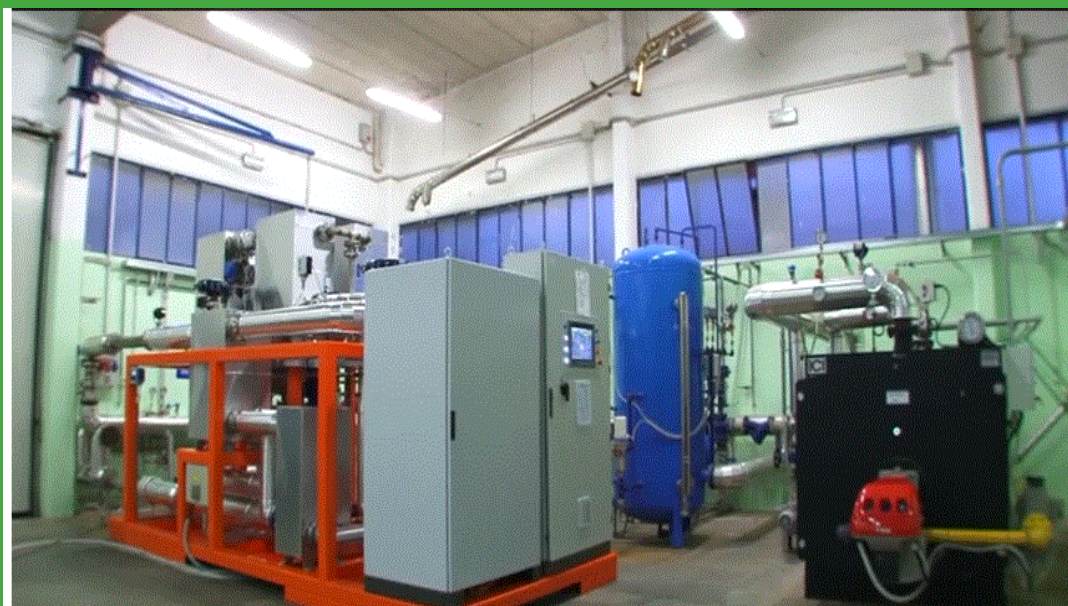
Primo piano-skid di turbina ORC-LT all'interno di un'impianto.
