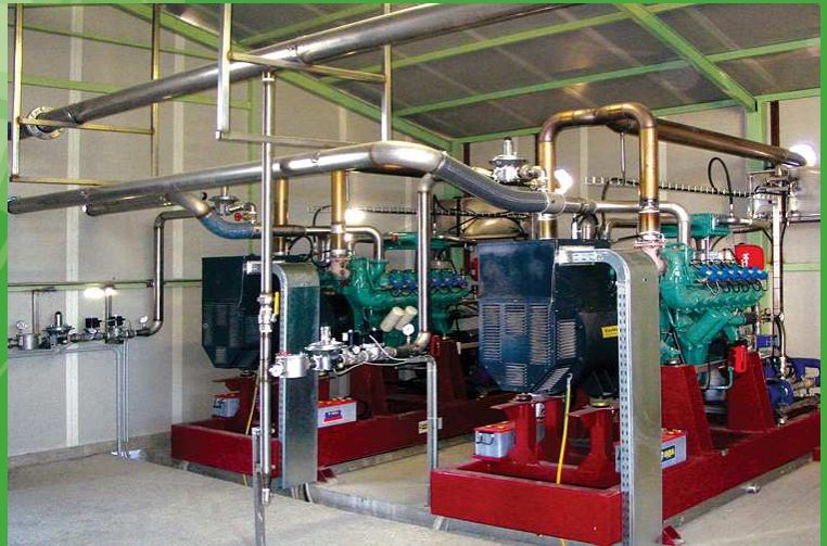
Esempio di un impianto di cogenerazione - interno
